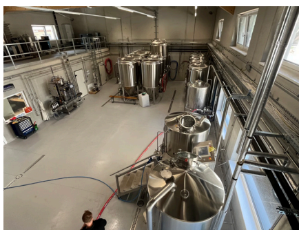
Neue Brauhalle am Standort Pyhra © Erhard Kührer
